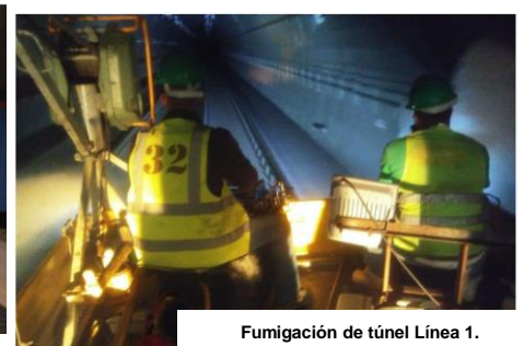
Fumigación de túnel Línea 1.
